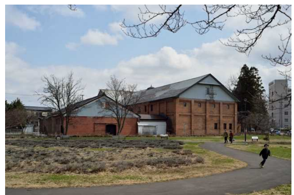
吉野町煉瓦倉庫 外観
